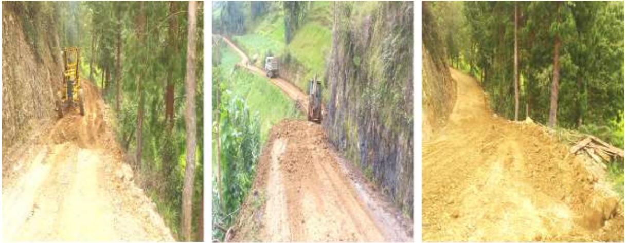
Vía de Acceso al Rio Ilso
