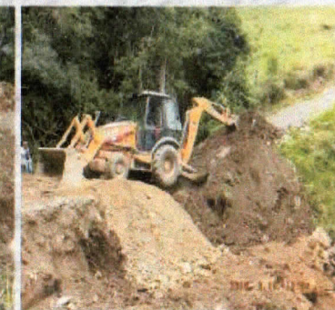
LIMPIEZA DE DERRUMBES, PASOS DE AGUA Y COLOCACION DE TUBERIA EN LA VIA CRISTO REY-COLLAY
