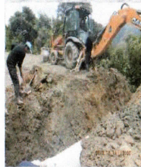
LIMPIEZA DE DERRUMBES, PASOS DE AGUA Y COLOCACION DE TUBERIA EN LA VIA CRISTO REY-COLLAY
