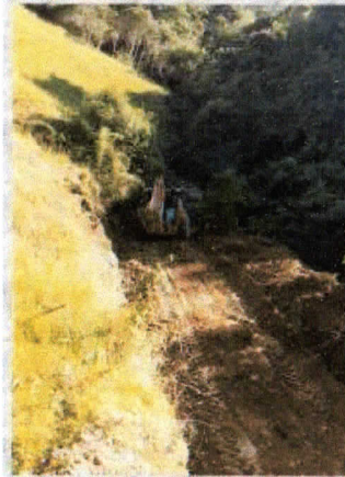
LIMPIEZA DE DERRUMBES, PASOS DE AGUA Y COLOCACION DE TUBERIA EN LA VIA CRISTO REY-COLLAY
