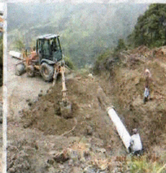
LIMPIEZA DE DERRUMBES, PASOS DE AGUA Y COLOCACION DE TUBERIA EN LA VIA CRISTO REY-COLLAY
